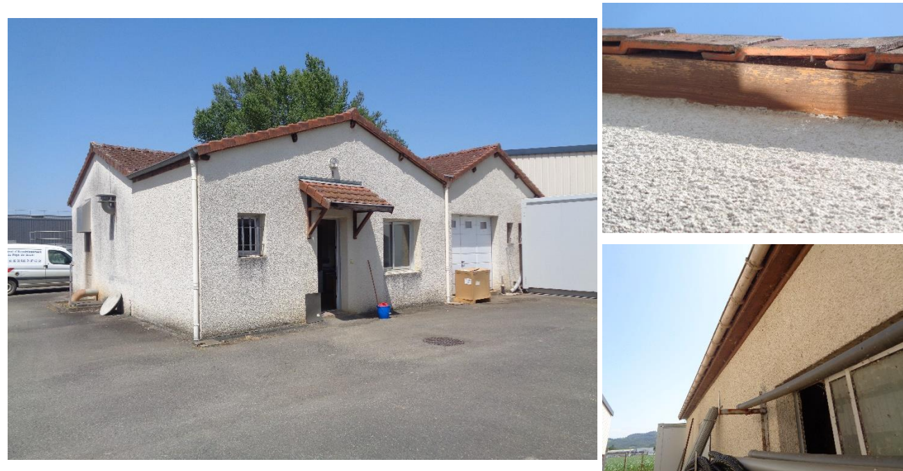
Figure 15 : Bâtiment d'exploitation inspecté pour les potentialités en gîtes (Elsa FERNANDES - © ECOTONE)
